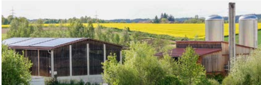
Biomasse-Heizwerk in Rinning mit Stadtwerke Nahwärmenetz - innovativ und klimaschonend © StWD
