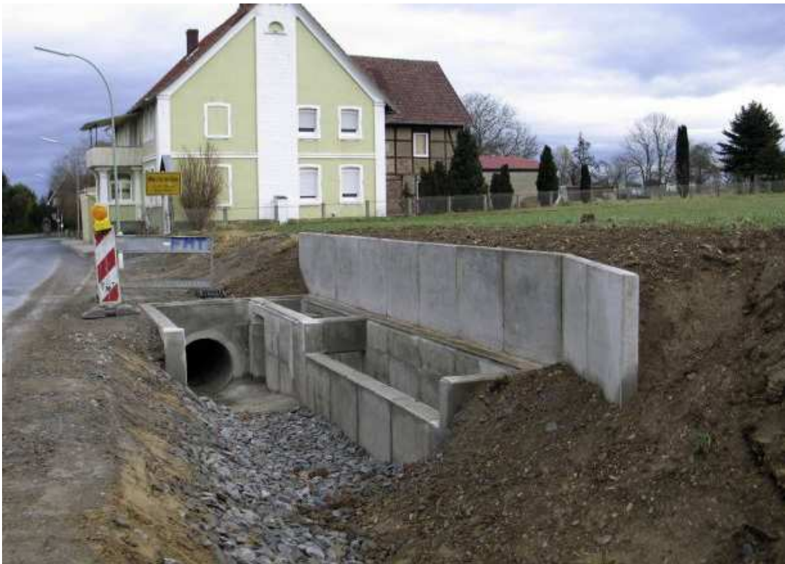
Abb. 5: Überlauf-Umleitung eines Gewässers vor einer Engstelle (Drosselbauwerk)
