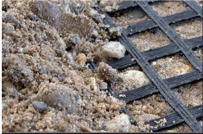
Abb. 6: Geotextil für Bewehrte Erde Quelle: Originalbilder Fa. Huesker, Internet
