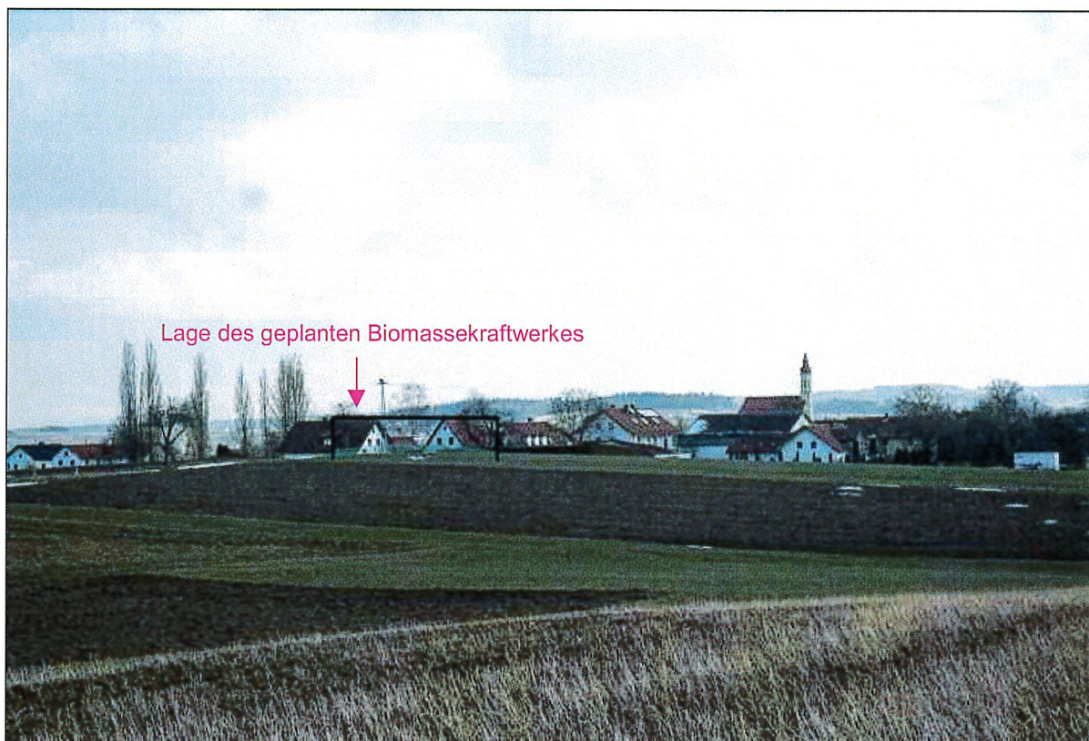
Blick auf das Plangebiet von Nordwesten. Die Filialkirche St. Peter wird durch das geplante Biomassekraftwerk nicht beeinträchtigt.
