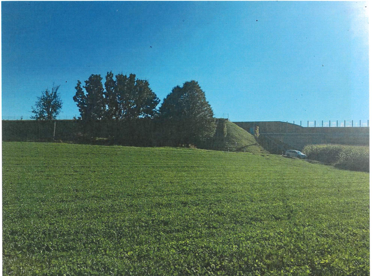
Abbildung 6 - Blick Richtung A94 aus Richtung Schiltern Nord
