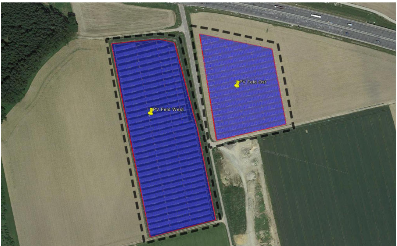
Bild 2.1.3: Detailansicht der PV Flächen (Quelle: Google Earth/SolPEG)
