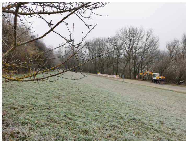
Abb. 10 Stollnkirchener Straße südwestlich des Plangebiets, Blick in Richtung Südosten
