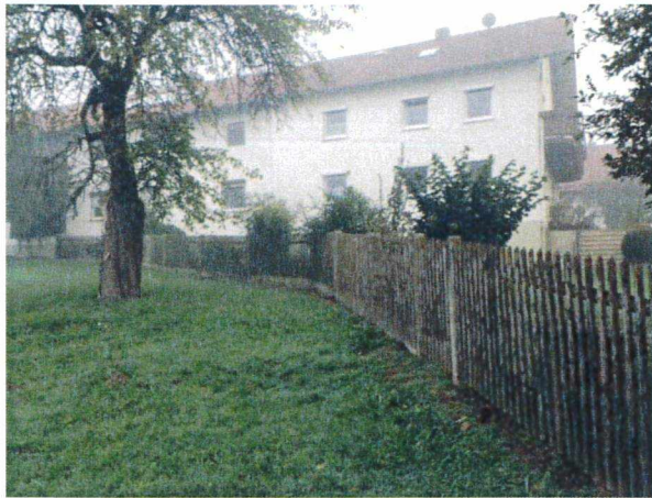
Foto Nachbargebäude, Hausnr. 16 (Flnr. 1125)
