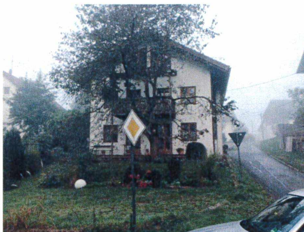
Foto Nachbargebäude, Hausnr. 20a (Flnr. 1122)
